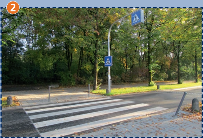
Fußgängerüberweg Weißenseestraße vor der Schule
